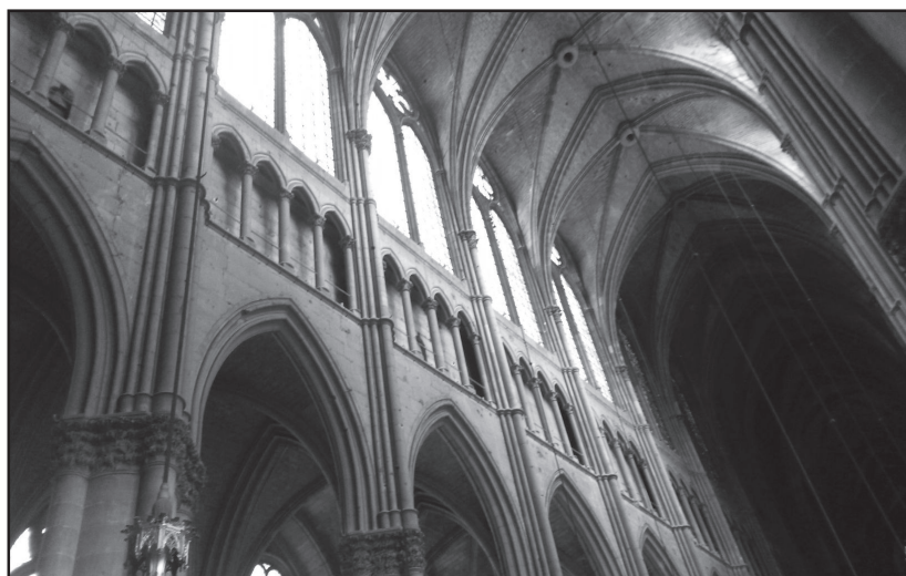
wnętrze nawy katedry – ściany boczne i fragment sklepienia
