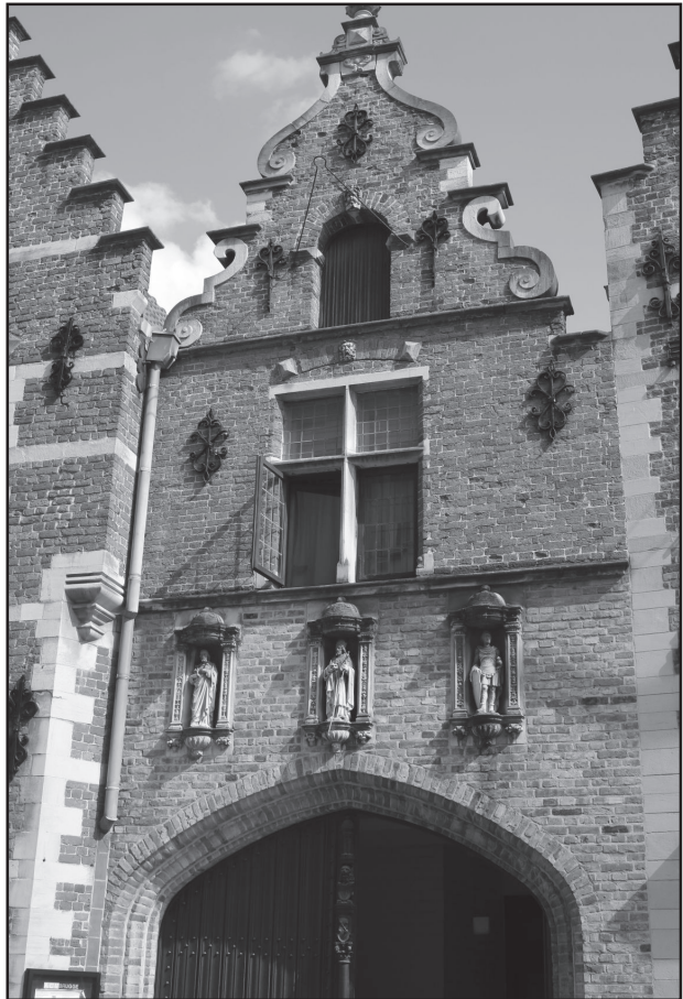
piękny szczyt kamienicy
