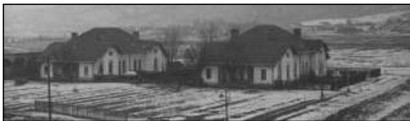
Czterorodzinne domki fabryczne nad Sanem, przy ulicy Reymonta (wyburzone w połowie lat 70-tych).
